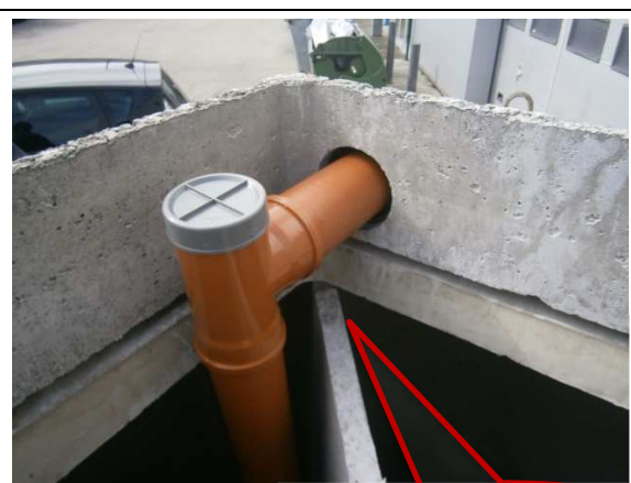
Connexions internes équipées d'origine
